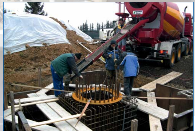
Fundamentherstellung für einen Funkmast.
