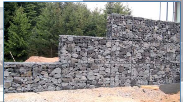
Erstellung von Gabionenwänden mit Bruchsteinfüllung
