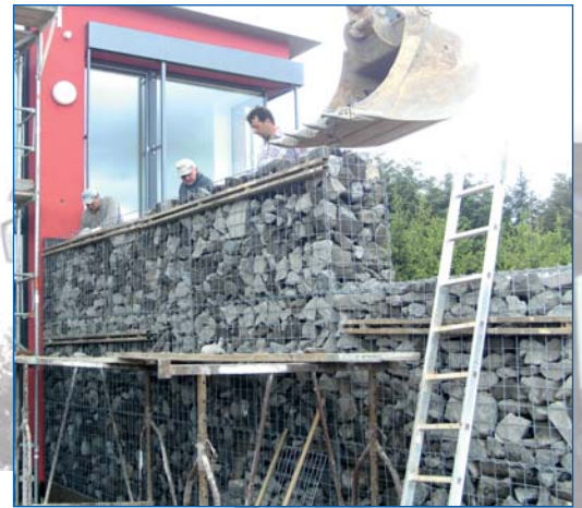
Erstellung von Gabionenwänden mit Bruchsteinfüllung
